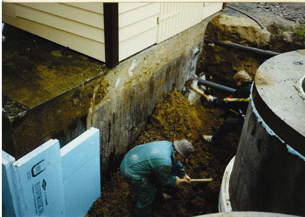
Aufnahmen von Sanierungs- und Erweiterungsarbeiten durch Mitglieder des Fördervereins Waldschwimmbad
