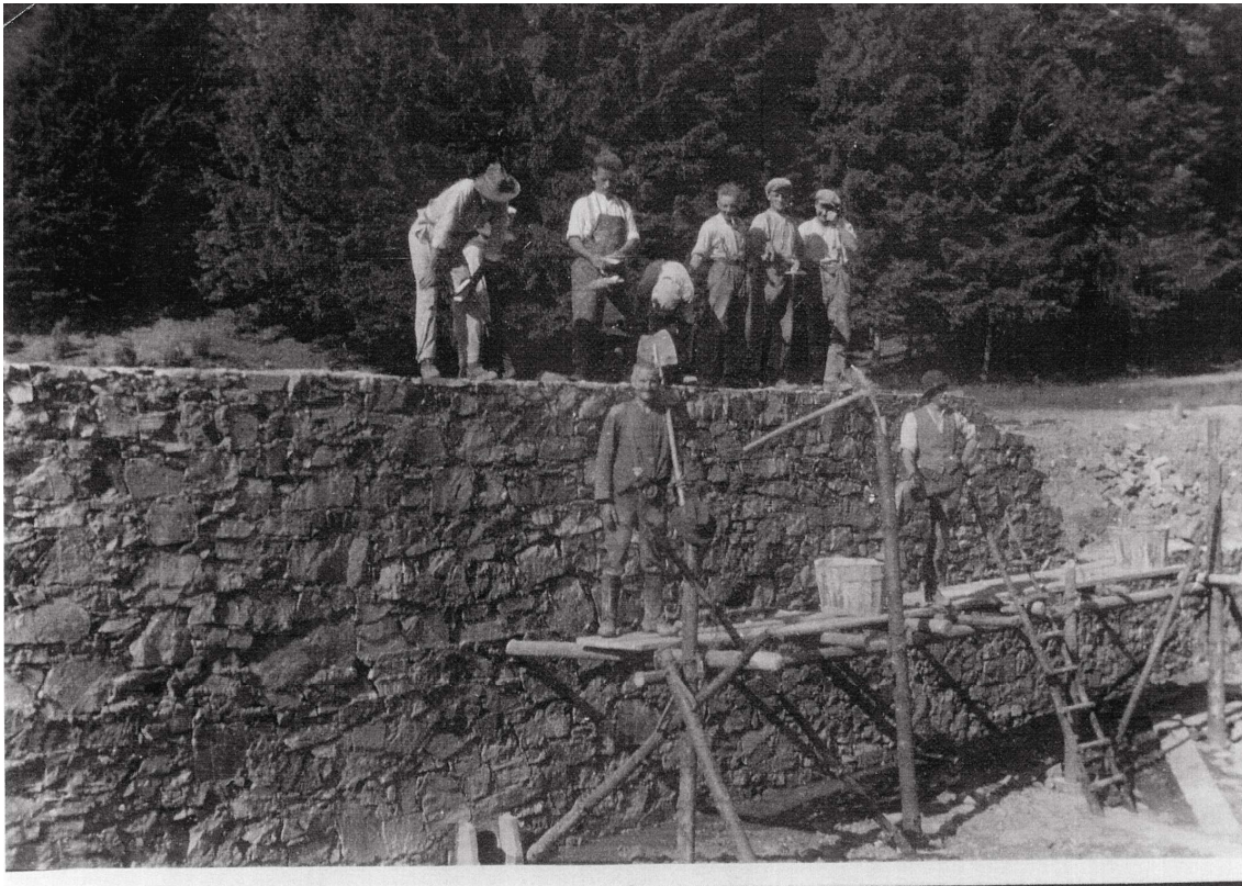
Auf der Mauer: 1. von links Heinrich Abel, 2. Jakob Becker, 3. unbekannt, 4. Adam Kaletsch, ganz rechts Karl Rühl; auf dem Gerüst von links: Ludwig Schmidt und Peter Becker
